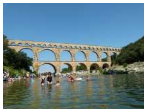
Le pont du Gard bien encombré
