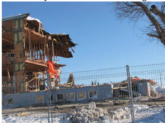
La démolition d'une école de Malartic
